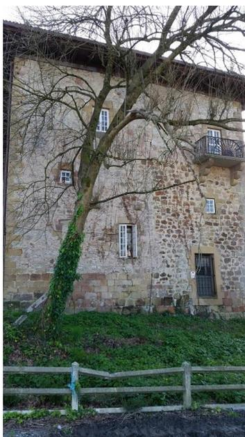
*La fachada posterior se apareja en mampostería, pero aquí la sillería arenisca forma un paño de considerable extensión y homogeneidad – la mitad de la planta baja- extendiéndose en su parte inferior por toda la anchura del edificio, y dejando además a la vista la existencia de un zócalo de asentamiento, invisible en las otras caras debido a las alteraciones del terreno circundante.*
